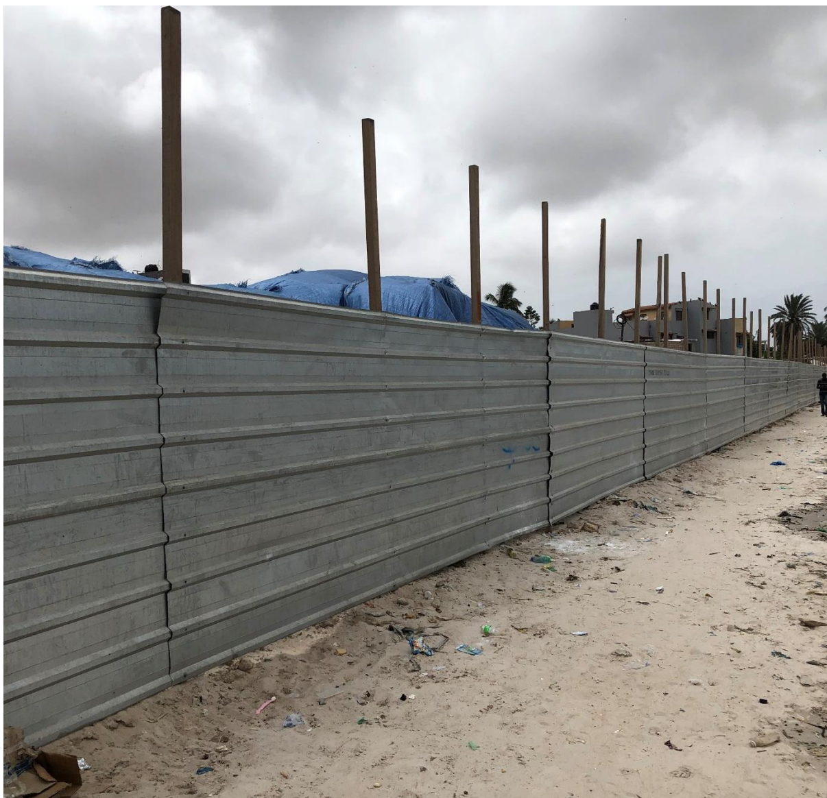
Figure 7 : Chantier en cours de construction du complexe frigorifique de Hann
